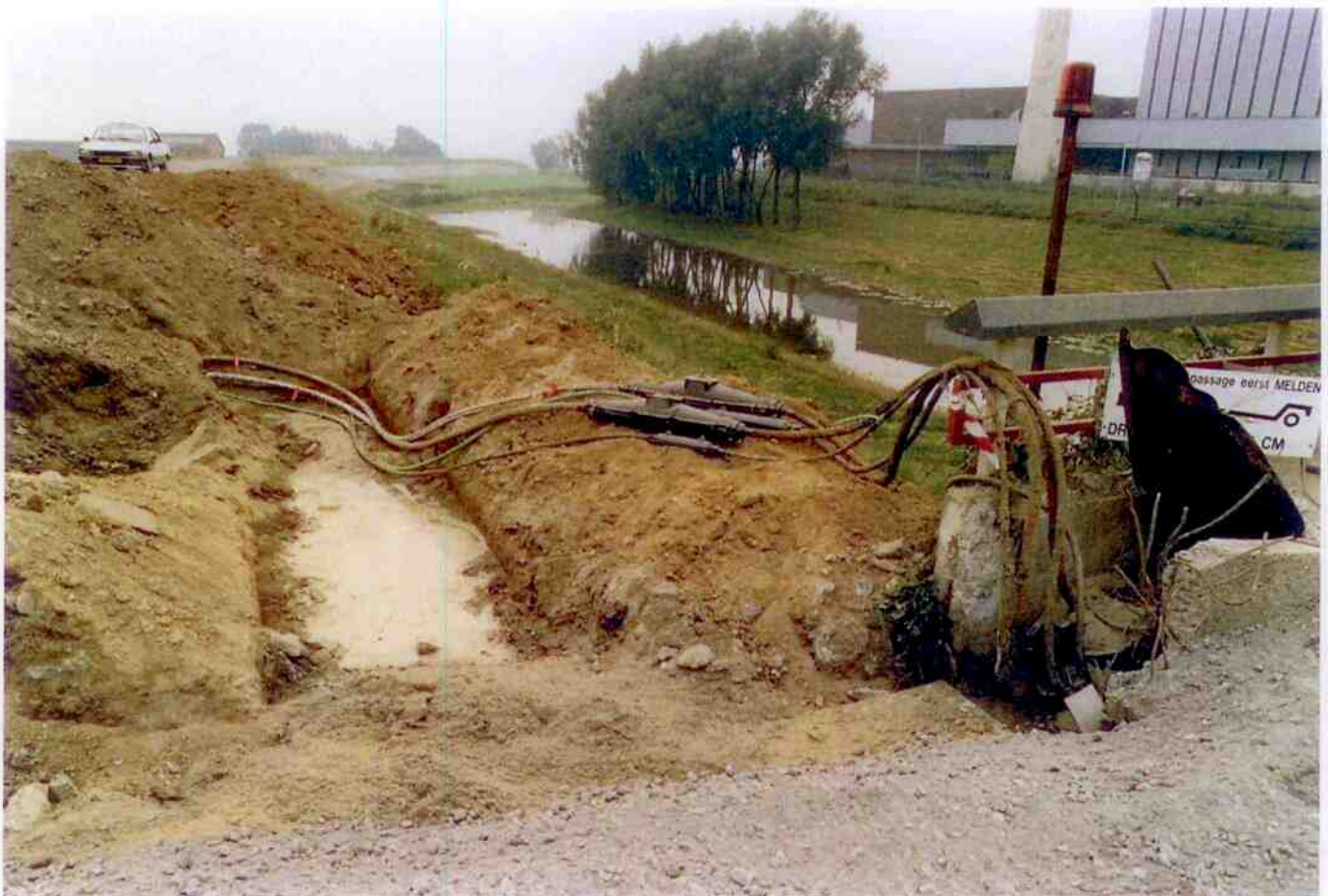
Werkzaamheden ten behoeve van de dijkverzwaren.
